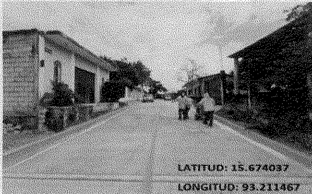
PAVIMENTACION CON CONCRETO HIDRAULICO
